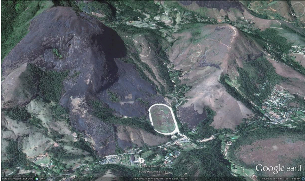
Figura 18 - Vista de toda a bacia de captação em torno do Haras, sendo a que mais contribuiu para a inundação do Rio Cuiabá. Contribuiu cerca de 58% da água do Cuiabá e 37% do Rio Santo Antonio
