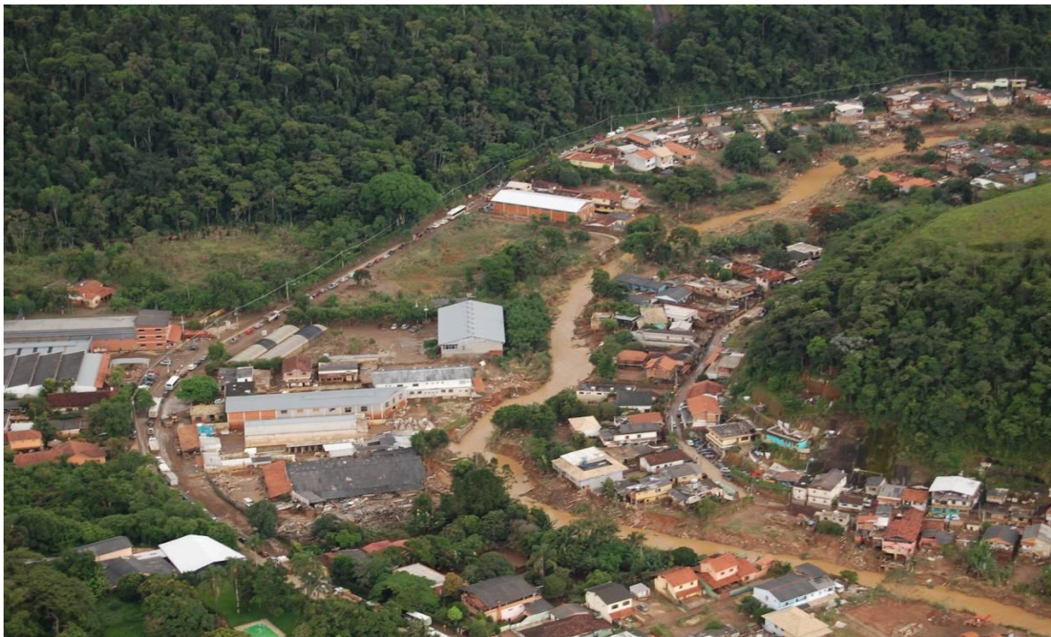
Figura 4 - Foto aérea exemplificando como o Rio Santo Antônio necessita de uma calha muito larga para comportar toda a água vinda do Rio Cuiabá e do Rio do Jacó.
