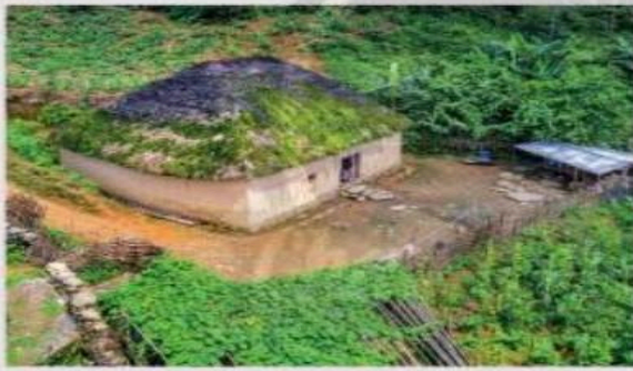
1. Nhà trình tường ở Lào Cai
