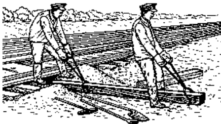
Рисунок 5.19 - Вытаскивание и затаскивание шпал
