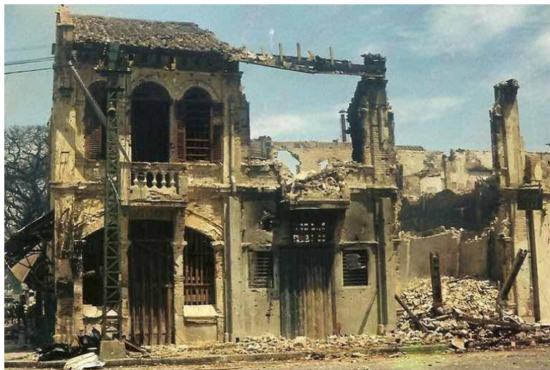
Nhà số 31 đường Kim Biên, quận 5 trở thành đồng gạch vụn.
