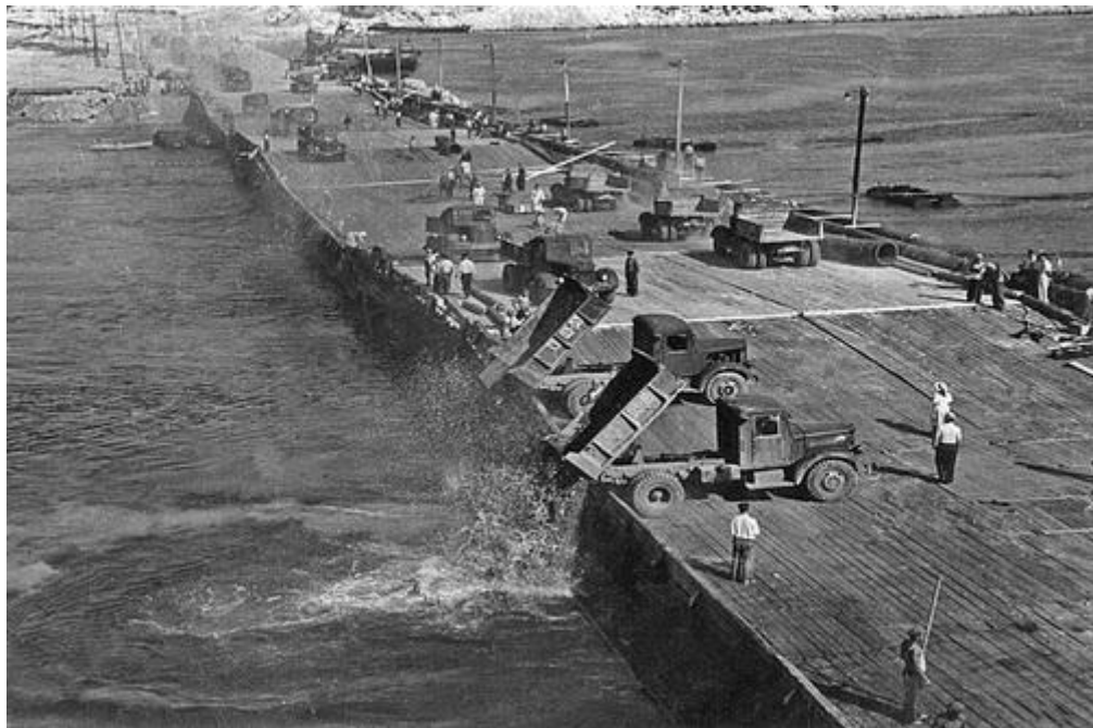
Мал. 2. Будівництво Каховської ГЕС.
