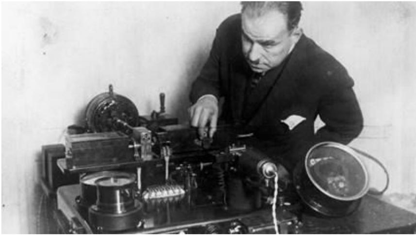
Передаваемое изображение закреплялось на прозрачном вращающемся барабане, луч света от лампы, перемещающейся вдоль оси барабана, проходил сквозь оригинал и через расположенные на оси барабана призму и объектив попадал на селеновый фотоприёмник.
