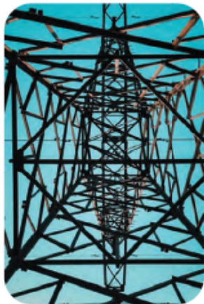
Gambar 4.13.3 Garis Lurus pada Menara Listrik
