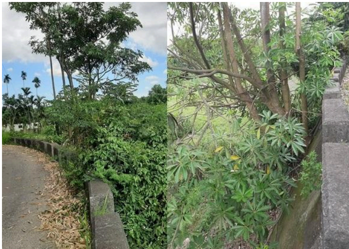
(左)原本會破壞邊坡擋土牆的樹木(右)由居民合力設法鋸除了
