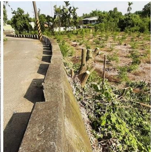
(左)原本會破壞邊坡擋土牆的樹木(右)由居民合力設法鋸除了
