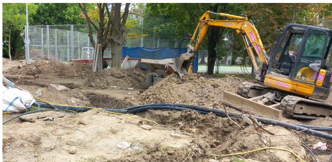
Excavación zanja colectores
