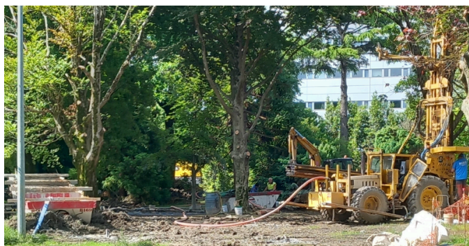
Máquina de sondeos de geotermia
