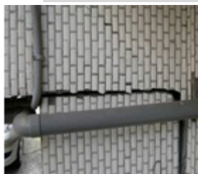
外牆柱斷裂
