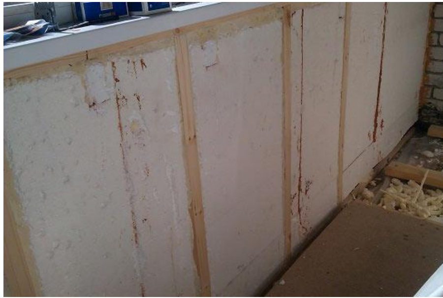
Готовий дерев'яний каркас для монтажу гіпсокартону в лоджії
