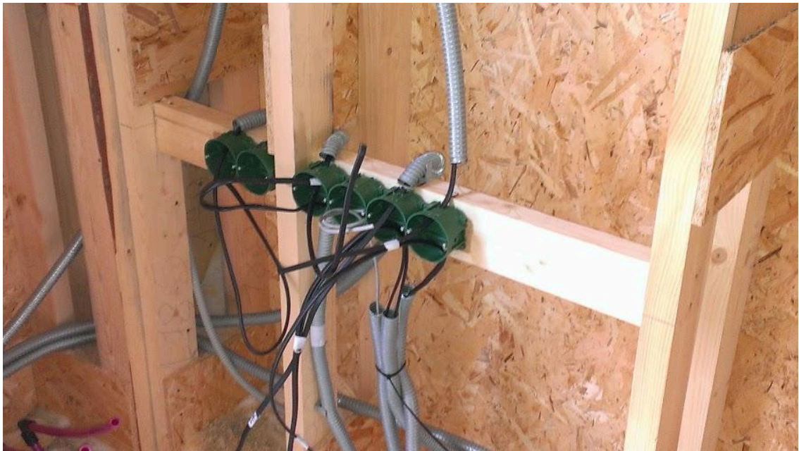
Встановлені коробки для розеток і вимикачів в дерев'яному каркасі
