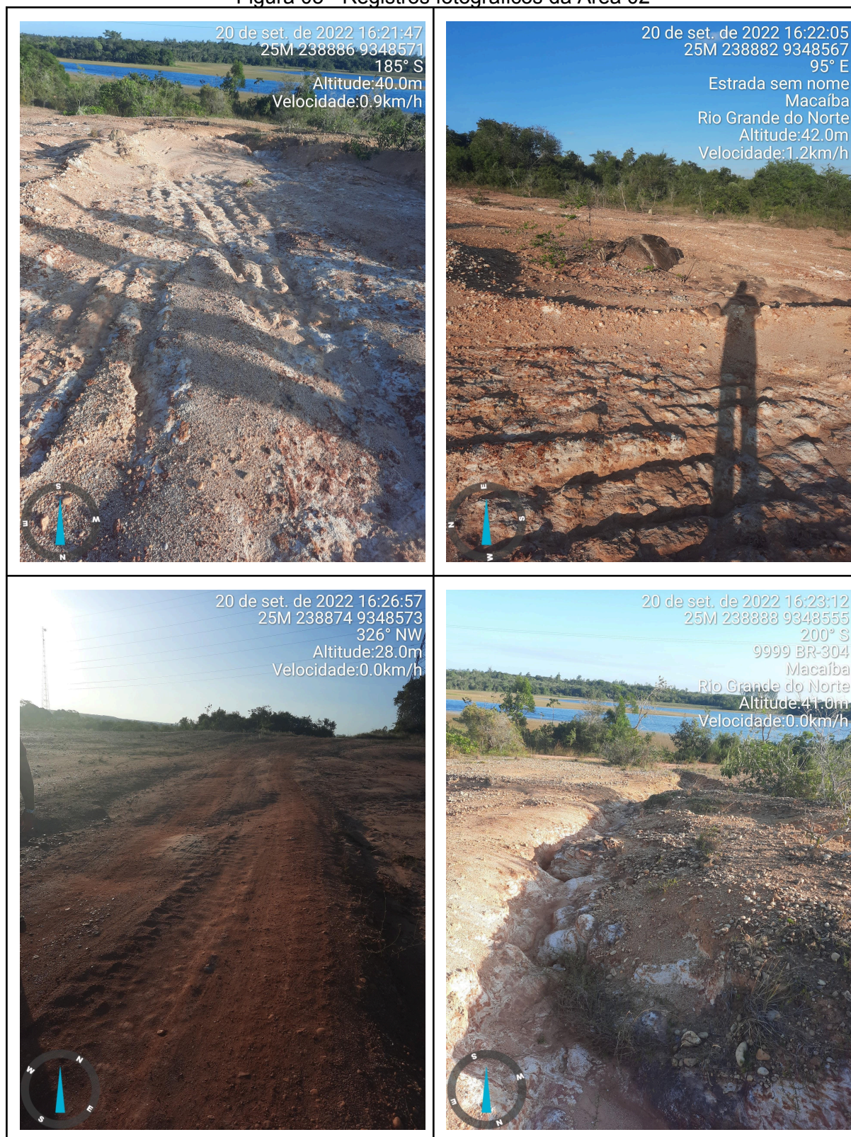
Figura 05 - Registros fotográficos da Área 02
