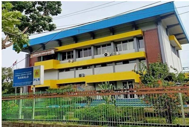
Gambar 1. 1 Gardu Induk 150 kV Rawalo
