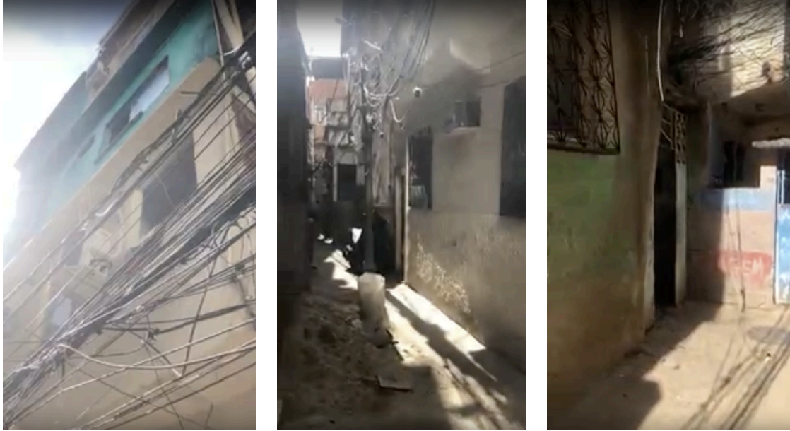
Imagens 01,02 e 03: fachada do prédio e construções vizinhas.
