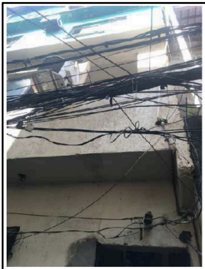
Imagem 01: fachada do prédio.
