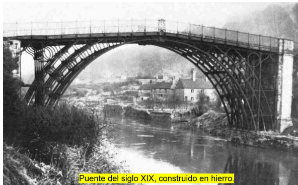
Puente del siglo XIX, construido en hierro
