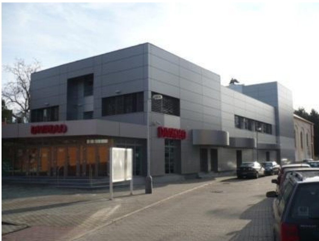
Uhřetěveské Divadlo U22 v pozadí s rekonstruovanou starou sokolovnou
