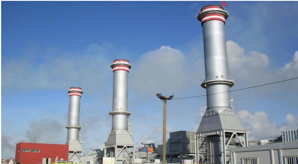
Figure 2 : Centrale Turbine à Gaz Mohammedia M2 (3*100 MW)
