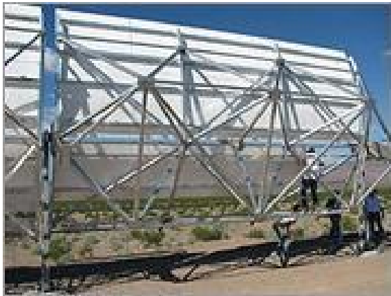
Figure 24 : Aspect du collecteur Eurotrough
