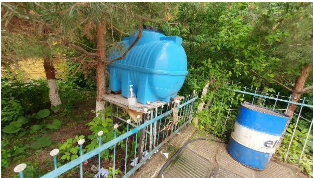
Фото 7 Резервуар чистой воды для питья учеников
