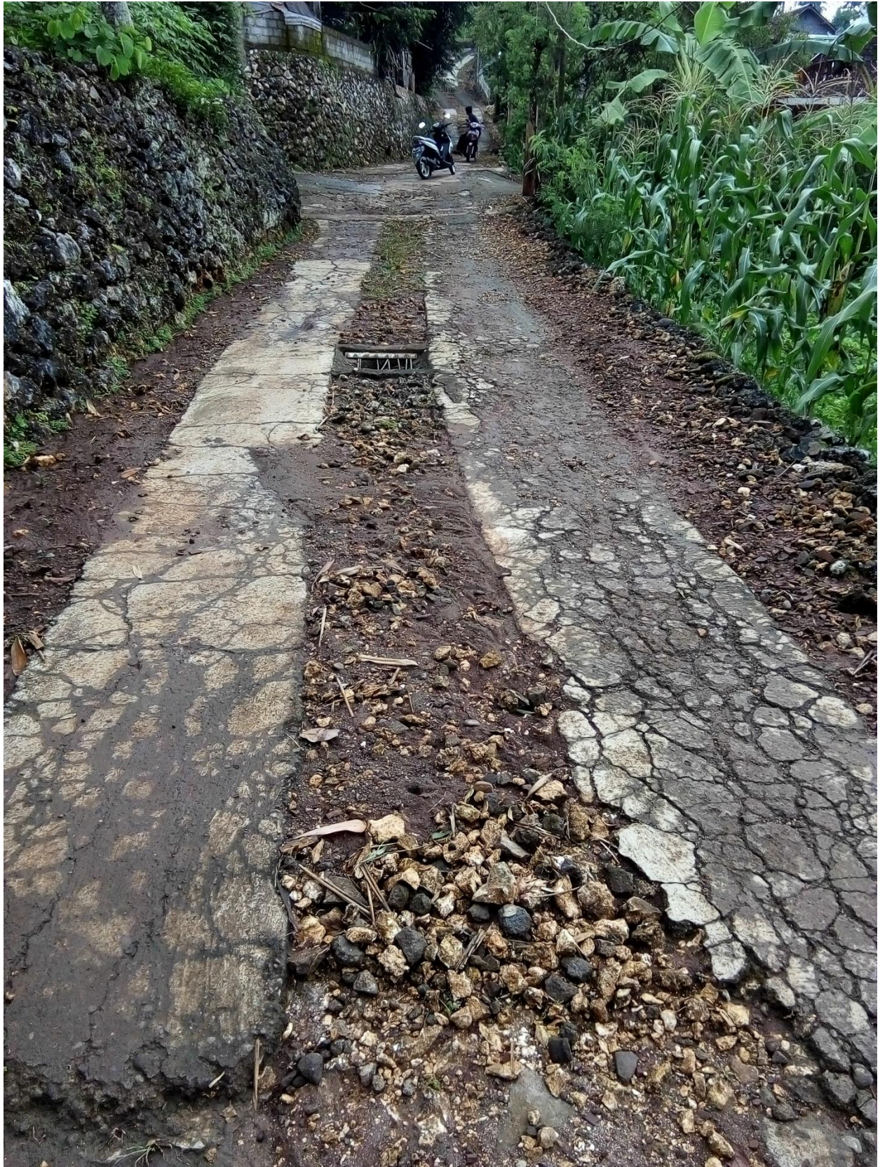
Foto 0% Lokasi Kegiatan Pembangunan
