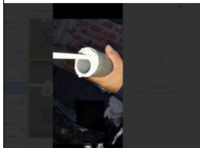
\*Pegar con espuma expansible el tubo de 2 pulgadas con el de 3 pulgadas.
