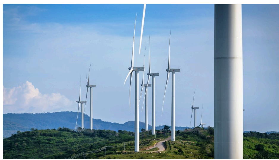
Các tháp tua-bin gió do PT Kenertec Power System (PT KPS) cung cấp cho Trang trại điện gió Sidrap, Indonesia. | Korindor News
