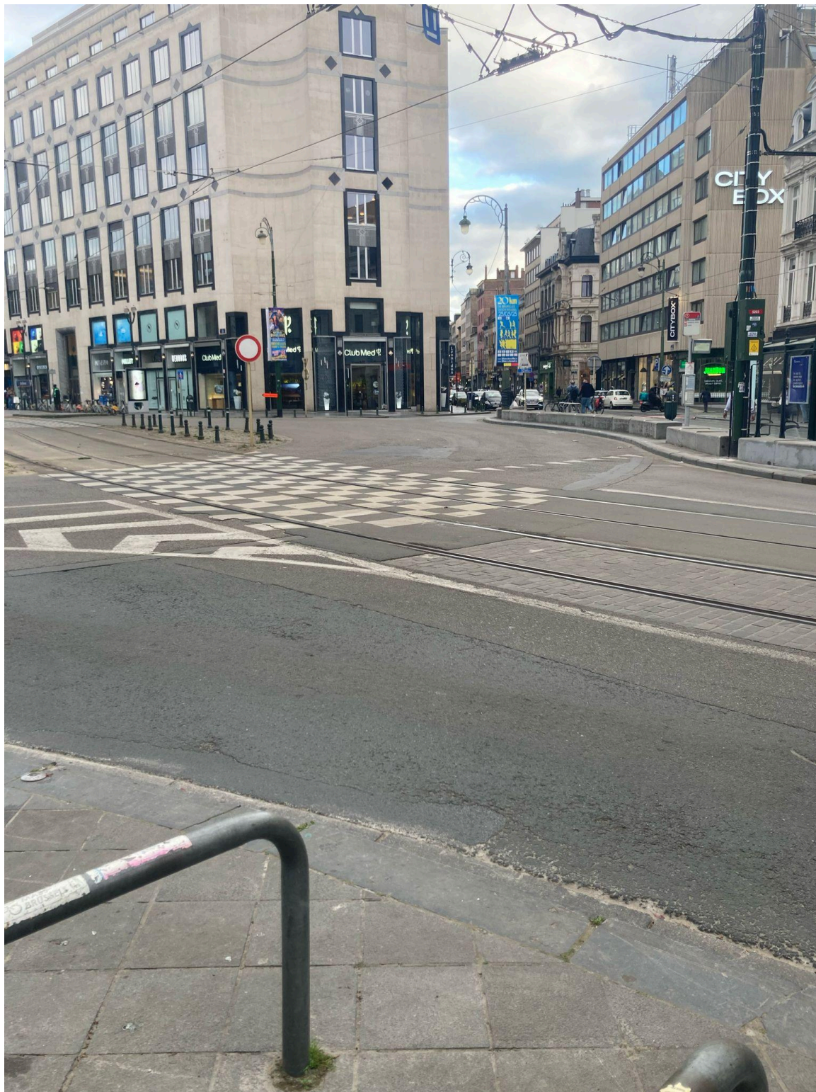
Chaussée de Charleroi - Route asphaltée, deux lignes de tram dans la rue (pour 60 m seulement)
