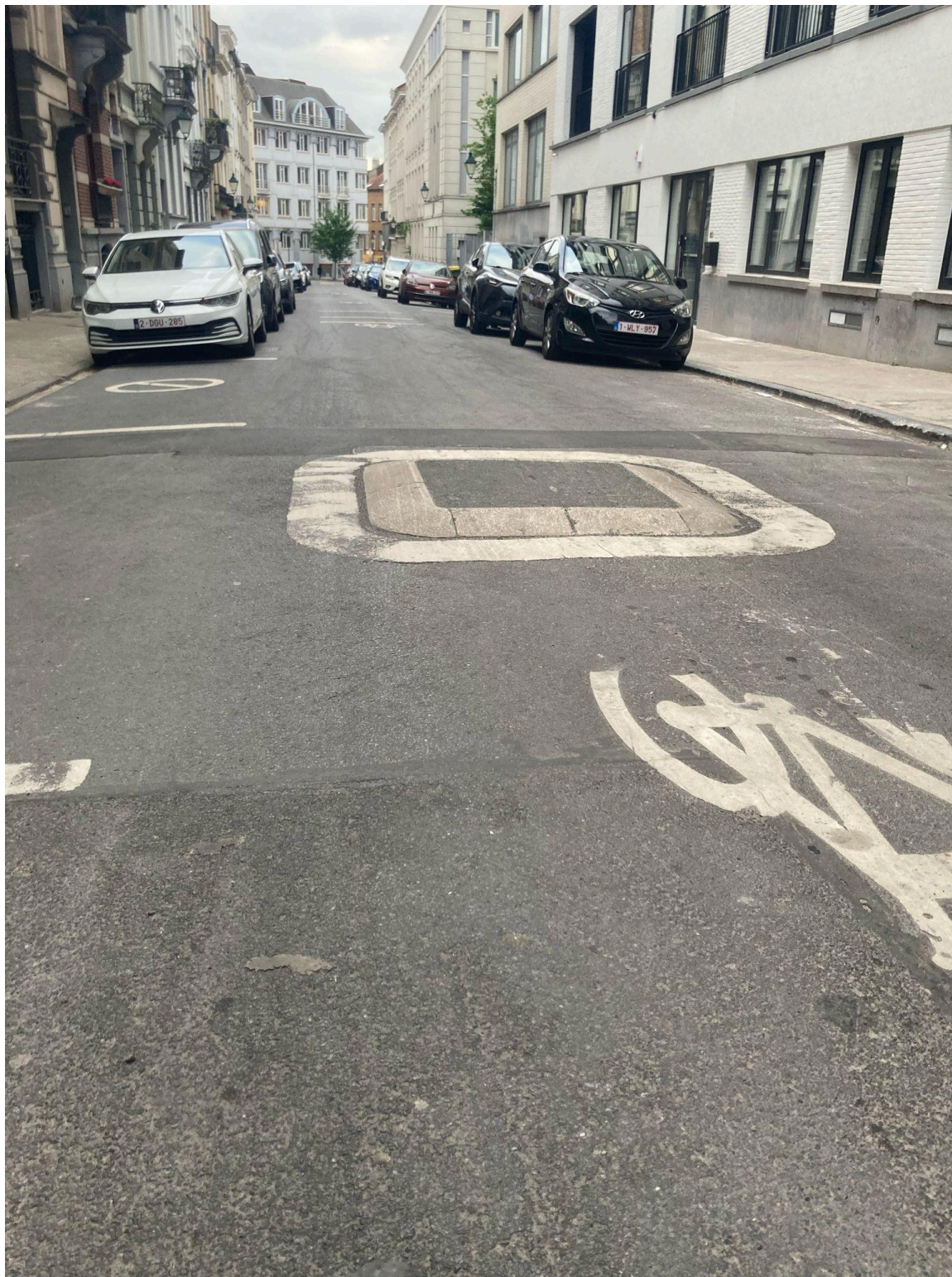
Rue de l'Hotel de Monnaies - Route asphaltée
