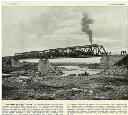
Общий вид моста через реку Яя. Линия Средне-Сибирской железной дороги пересекает реку Яю на 275 км, считая от ст. Обь. Перевод реки выбран на порогах моста деревни Шамарин; здесь берега реки крутые, и дно почти всегда скалистое, а в этом месте река почти не выходит из берегов. Река Яя перерывается наземным двухпутным мостом (2 фармаки отъезда, 25 с. кавалки, с вагоном поперек) частным отверстием 50 см. Мост возвышается над горизонтом воды приблизительно на 6 см. Имеет два береговых устоя и один рековой бунт с гидрозон, облицованным камнями чистой пещи (самый мост облицован тёмными серыми камнями, известными под названием «сибирского табора»; камень этот вымывается в 12 м от моста, в карьерах при деревне Успенка). Кладка береговых устоев — левого (обского) и правого (иркутского), начата осенью 1894 г., произведена в специально выстроенных для этой цели теплицах, отапливавшихся при помощи небольших железных печей, была закончена весной 1895 г. до открытия реки.
