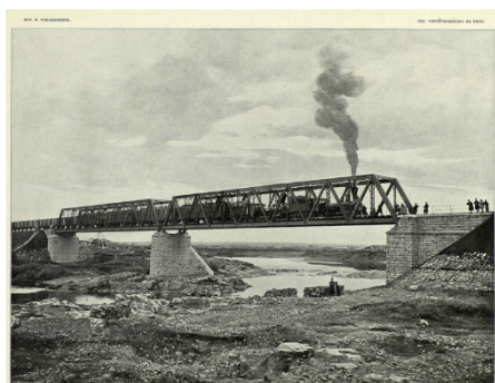
Общий вид моста через реку Яя. Линия Средне-Сибирской железной дороги пересекает реку Яю на 275 в, считая от ст. Обь. Перенос реки выполнен на порогах моста древними Шавергой, здесь берега реки крутые, и дно почти везде скалисто, в этом месте река почти не выходит из берегов. Река Яя перерывается металлом двухпролетным мостом (2 фармаком отс. 25 с. кажда, с водо-понузу частым отверстиям 50 см). Мост возвышается над горизонтом воды приблизительно на 6 саж., имеет два береговых устоя и один рековый бык с гидротермом, облицованными камнями чистой тесной (самый мост облицован тесными средним камнем, известняком под названием «сибирской габбро»); камень этот выкапывается в 12 в. от моста, в карьере при деревне Успенке). Кладка береговых устоев — левого (обского) и правого (иркутского), напечатана осенью 1894 г., произведена в специально выстроенных для этой цели теплицах, отапливавшихся при помощи небольших малых печей, была закончена весной 1895 г. до вскрытия реки.
