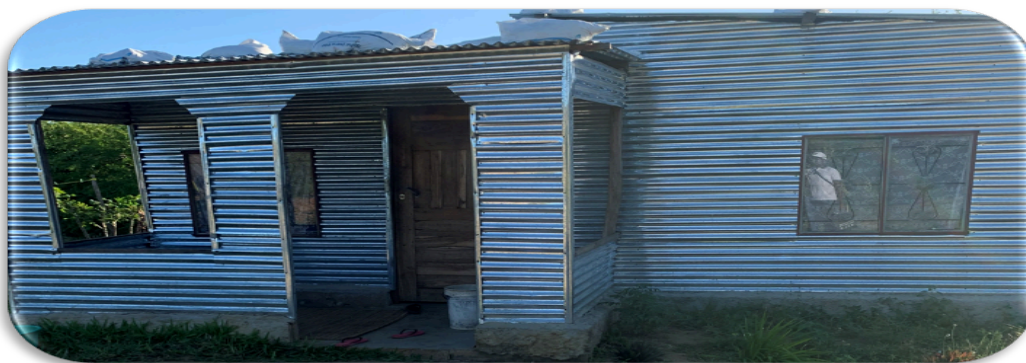
Figura 8: Casa de reassentamento provisória
