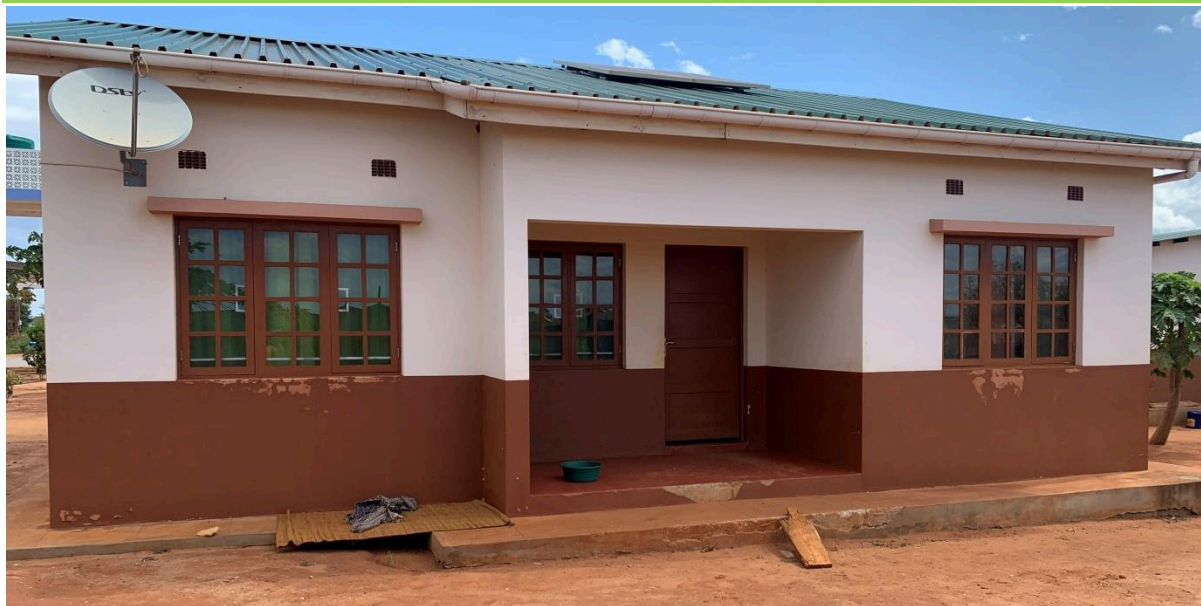
Figura 17: Casas concluídas (3) e entregue aos beneficiários
