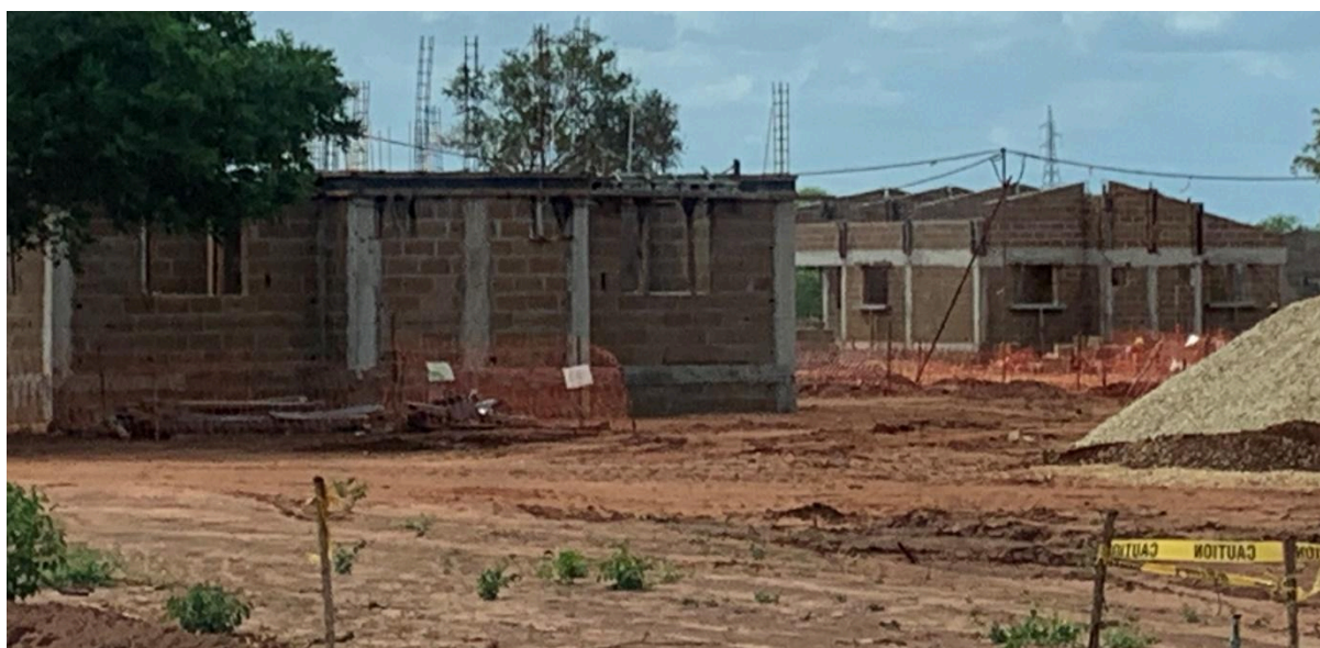
Figura 18: Casas em construção
