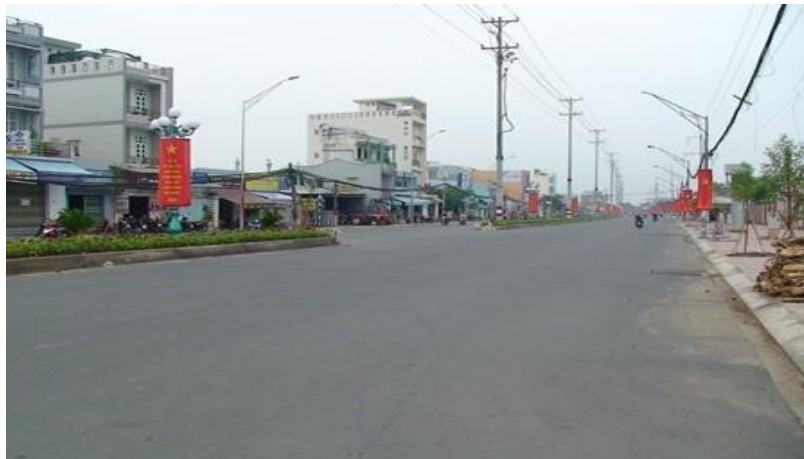
Mở rộng, nâng cấp QL1 đoạn qua TP Tân An
