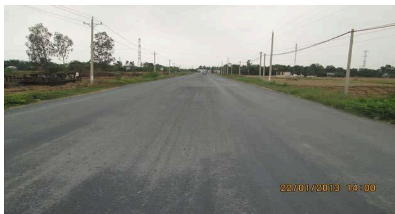
Đường Mỹ Yên - Tân Bửu
