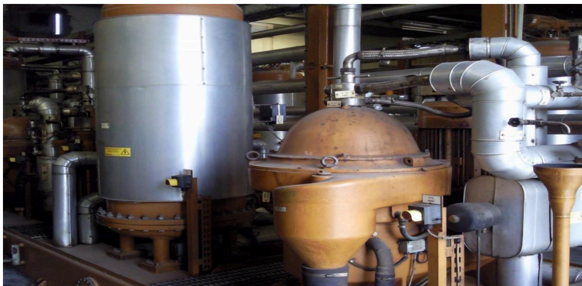
Figure 17 : poste traitement fuel
