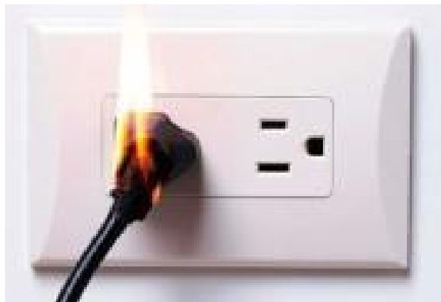
Gambar 6. Kabel listrik yang terbakar
