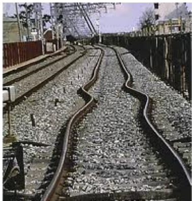
На этом рисунке видно, что происходит в жаркую погоду, если между участками рельсов оставлены неверные промежутки.
