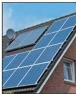
Мал. 38. Сонячні батареї на даху будинку
