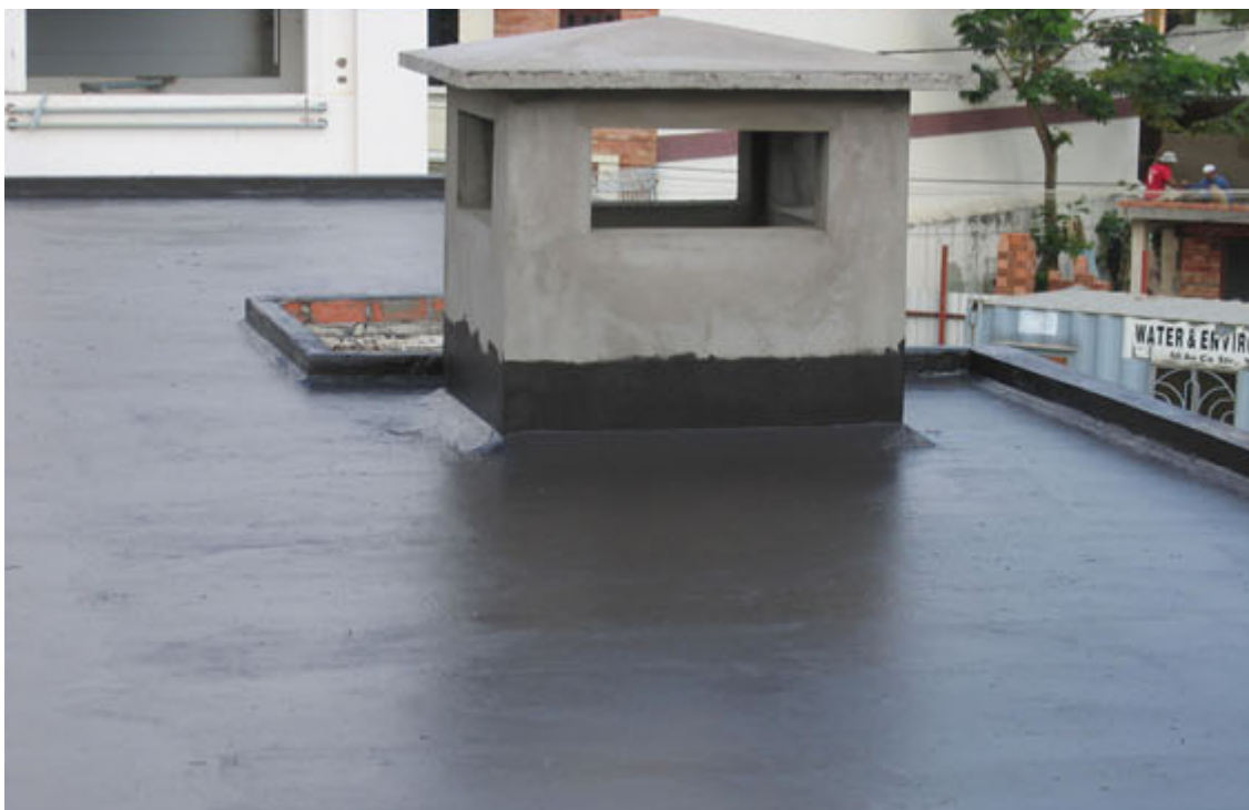
Chống thấm mái bê tông hiệu quả (9)
