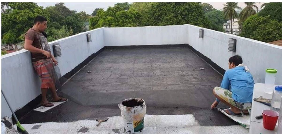
Sử dụng Flinkote để chống thấm mái bê tông hiệu quả (6)
