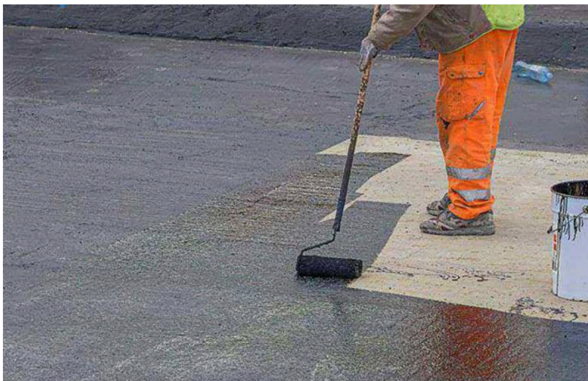
Sử dụng nhựa đường để chống thấm mái bê tông (5)
