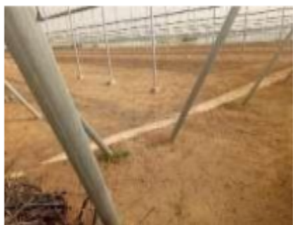
Figure n°5 : Nivellement de la terre
