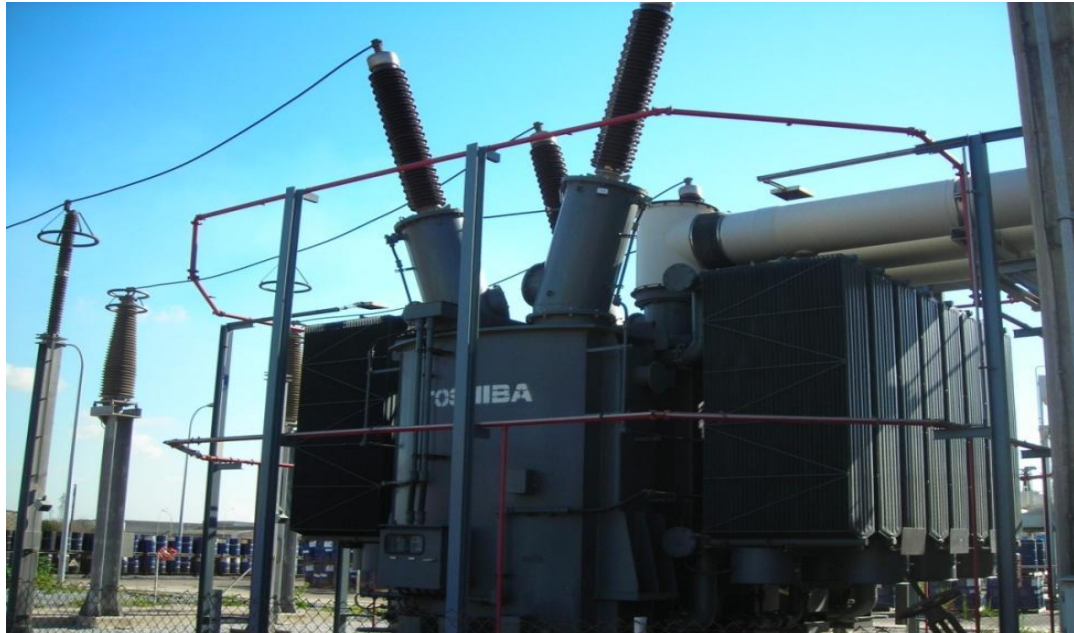
Figure 33 : Transformateur principale
