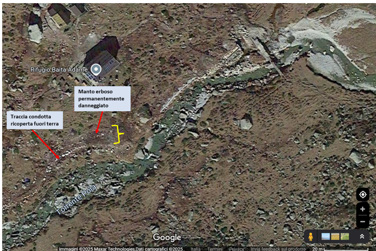
Figura 6 - Danni al suolo dovuti all'escavazione
