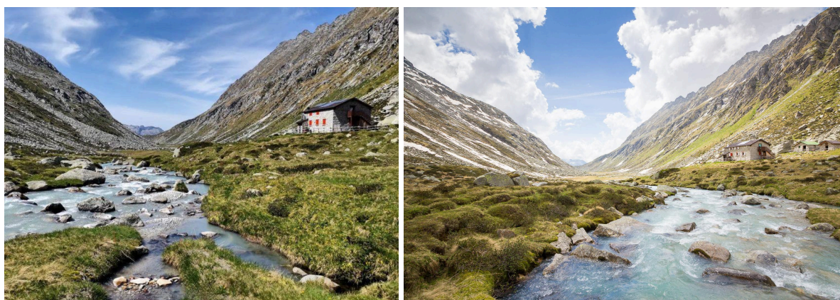
Stato dell'area pre-costruzione dell'opera “Idro Baita Adamè”
