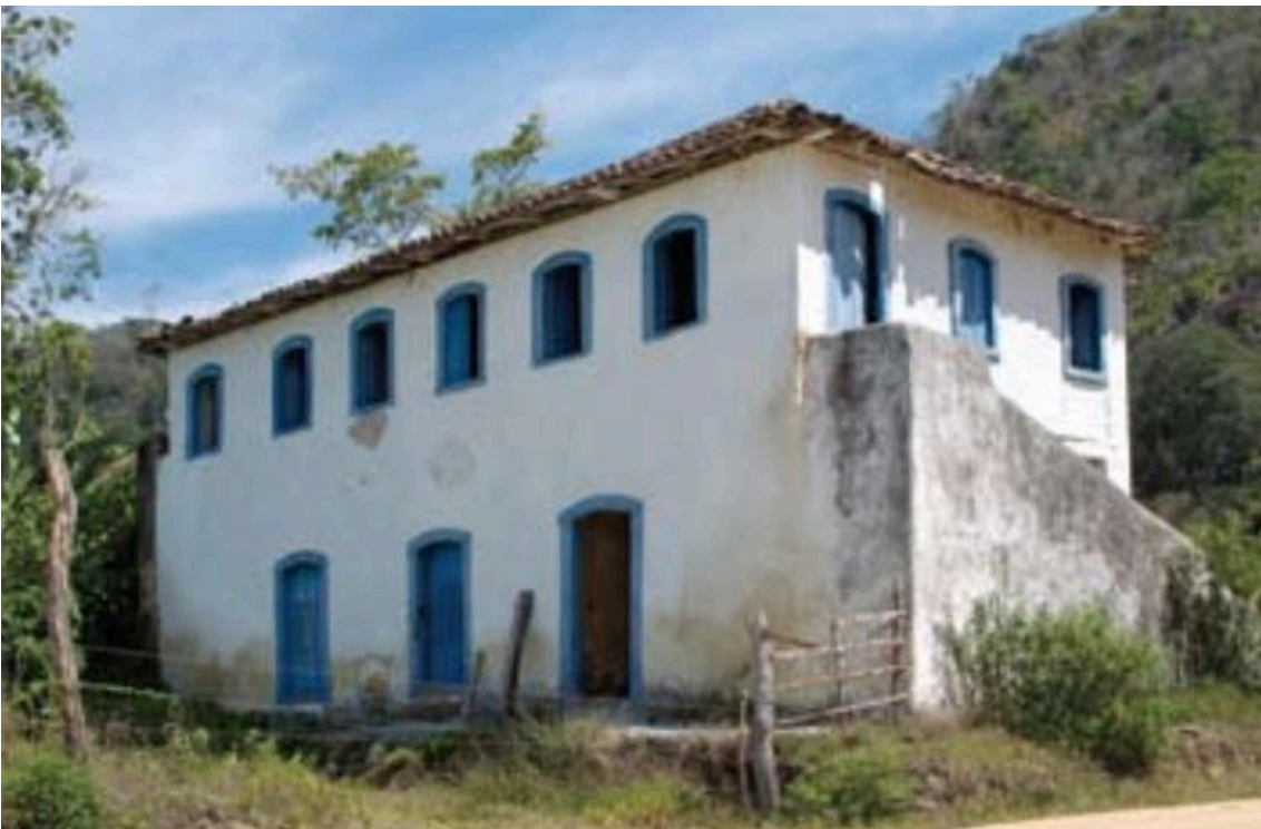
Descrição: Vista lateral do Casarão de Regência
