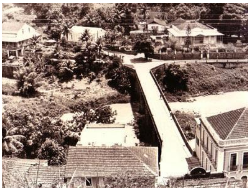
Descrição: Vista parcial da ponte sobre o rio Santa Maria da Vitória. Ano: 1981
