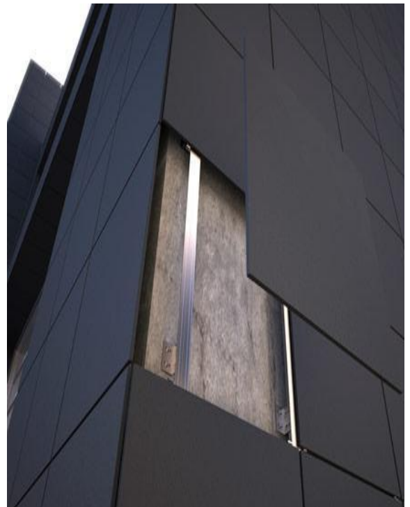
Рис. 5.8. Навісний вентиляований фасад із керамограніту та композитних панелей
