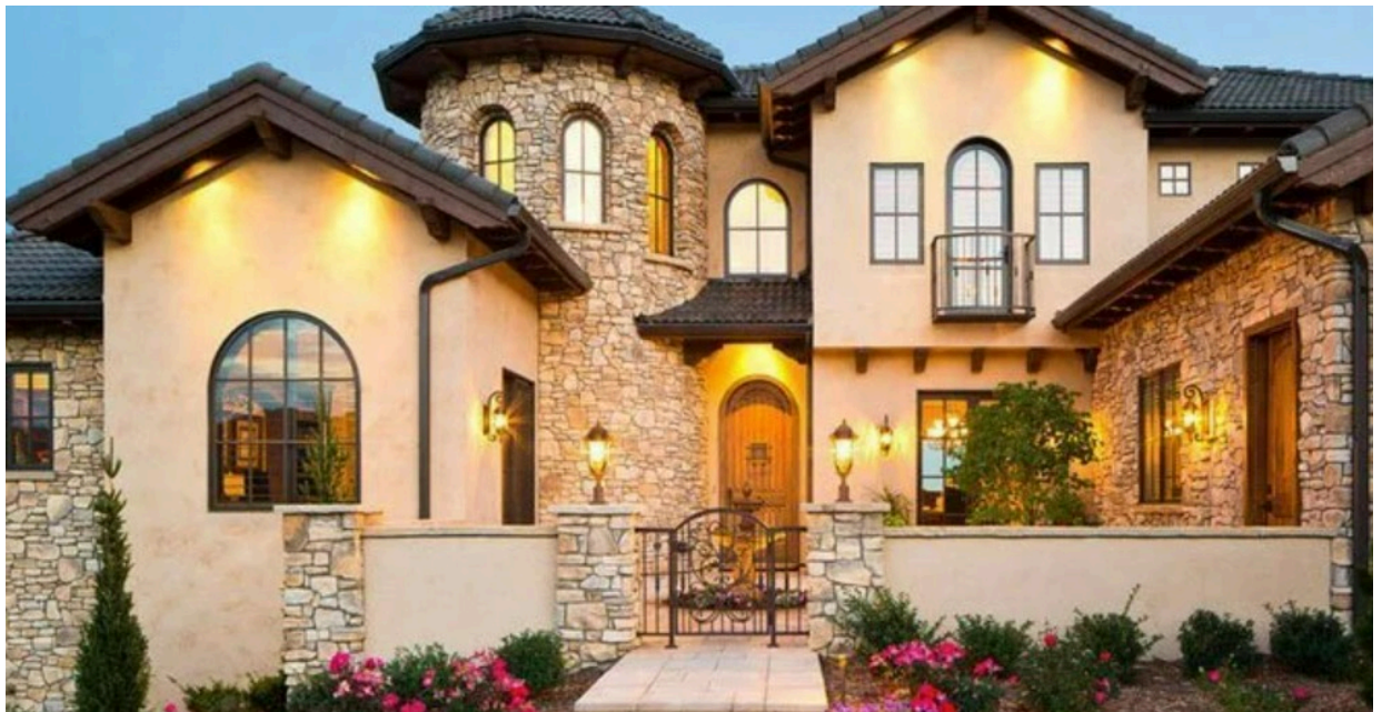
Рис. 4.11. Фасад, покритий світлою, теплою штукатуркою в поєднанні з круглим каменем «брудного» відтінку
