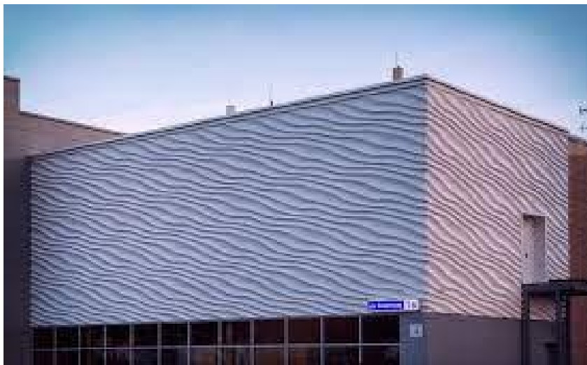
Рис.11.2. Перфорована оболонка фасаду зі склофібробетонних плит
