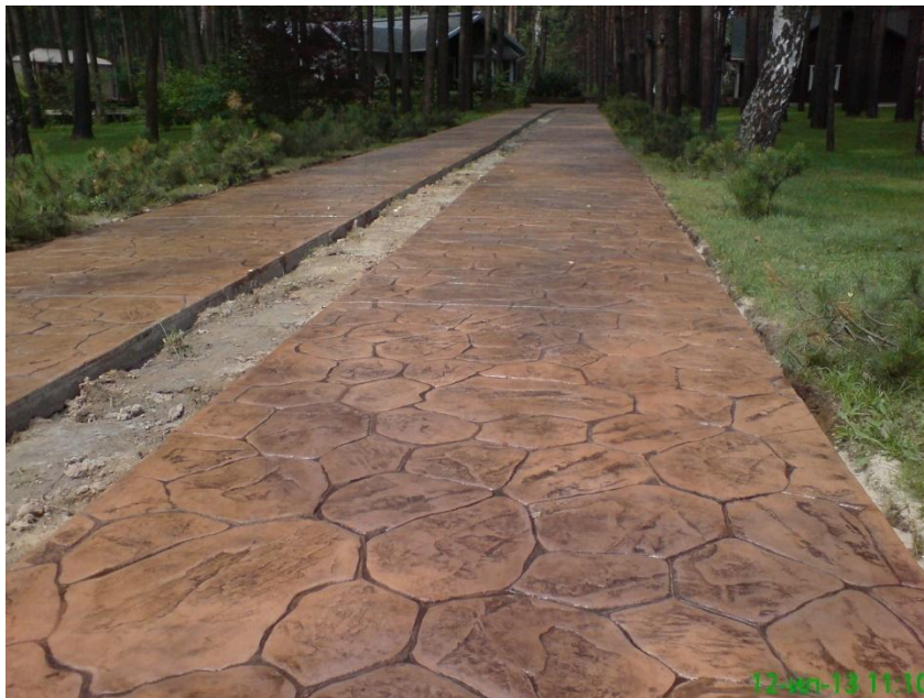
Рис.11.1. Декоративний штампований бетон
