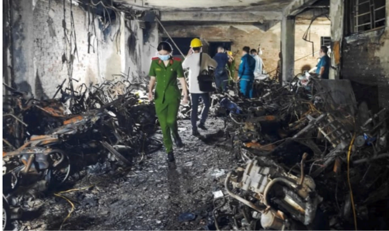
Hiện trường vụ cháy.
