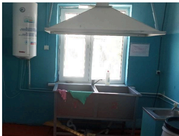
Рис.23, 24 – Местный вентотсос на кухне
