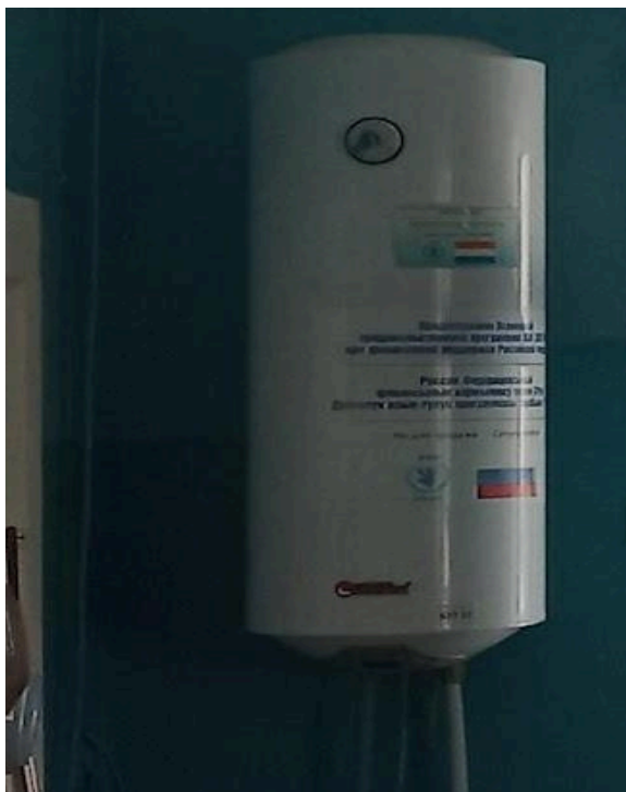
Рис.25 - Индивидуальная санитарная подготовка горячей воды
