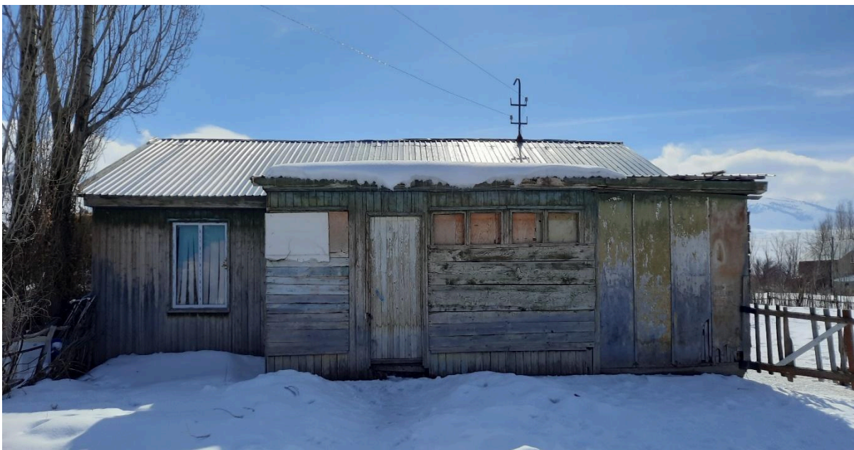
Рис. 13 – Здание служит как склад, книгохранилище, комната для настольного тенниса и кабинет тренера.
