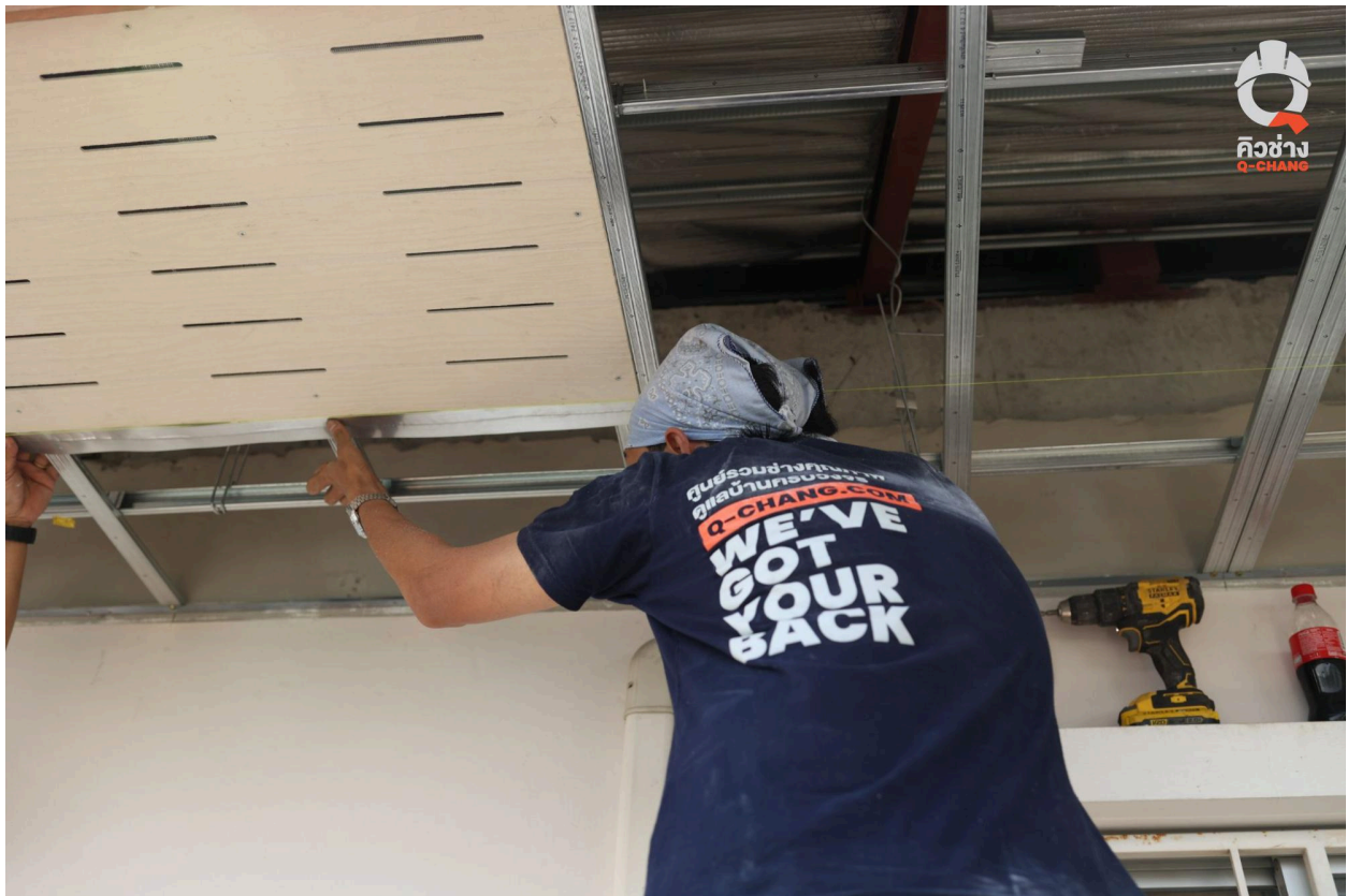
Alt : การติดตั้งฝ้าเพดานกันน้ำ
