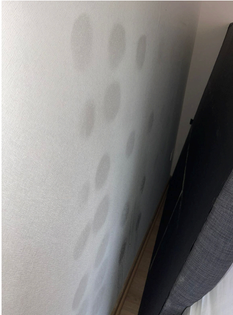
Condensación en pared tras respaldo cama
