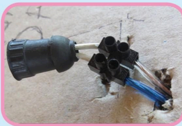
Sumber : Dokumen Kemdikbud Gambar 2.44. Terminal sambungan kabel
