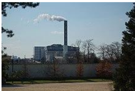
Incinérateur de déchets situé à Saint-Ouen .
