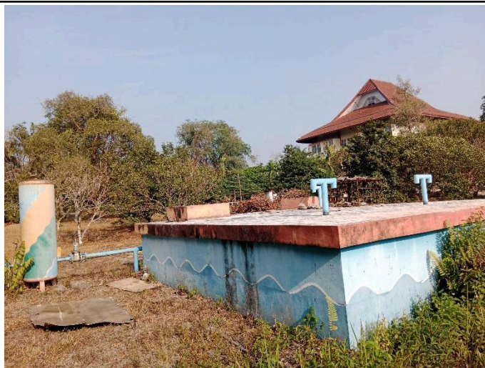
Gambar 1. Bangunan pengolahan air
