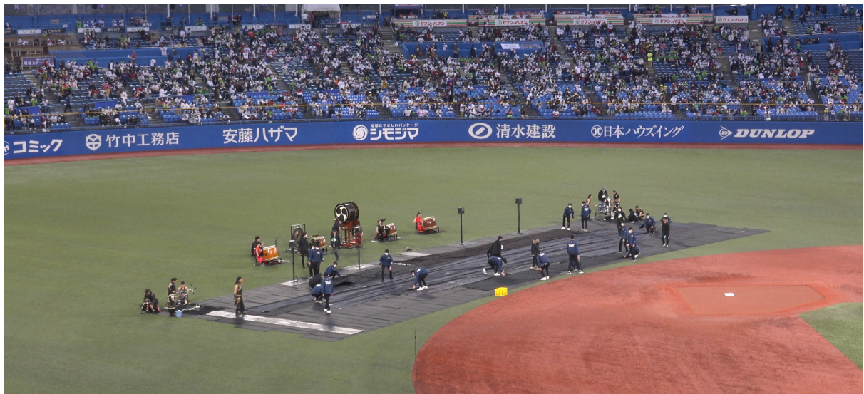
神宮球場での防災養生展開資料映像(設置10分程度、撤収5分程度)
