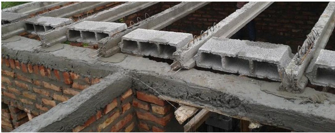
Lắp sàn panel
