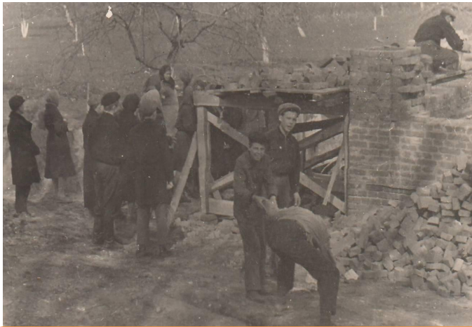
На будівництві шкільного спортзалу
