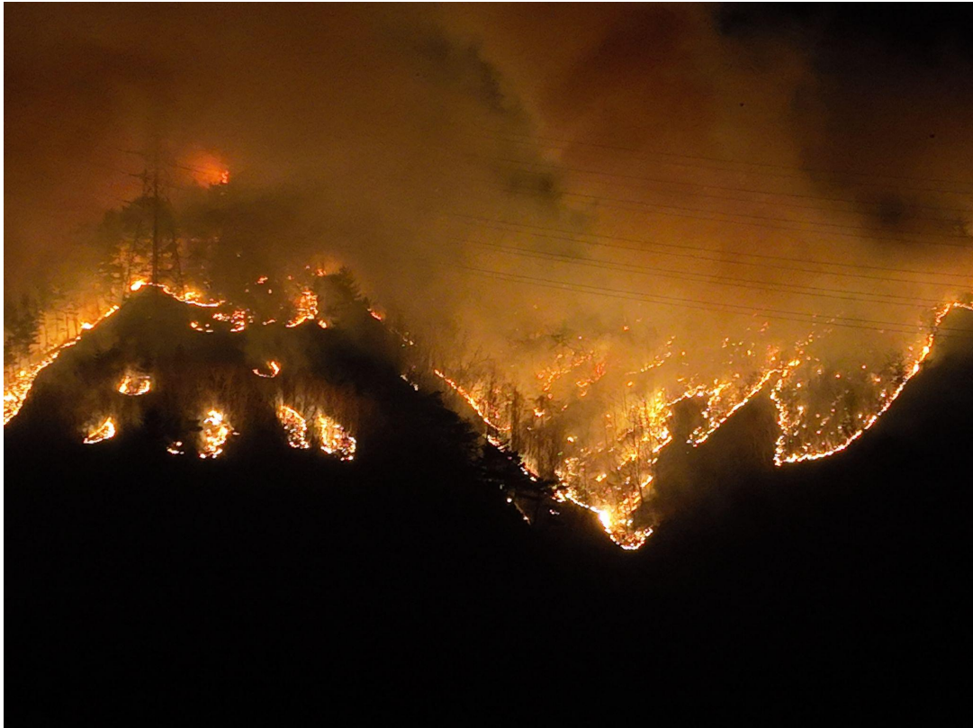
사진. 산불에 휩싸인 한울-신태백 345kv 송전선로
