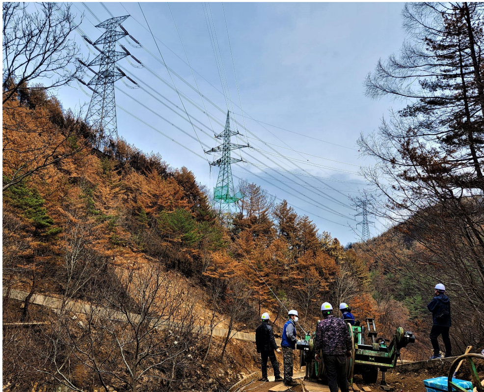
사진. 산불피해 송전선로 교체 작업
