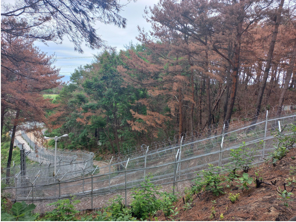
사진. 한울핵발전소 부지 내 산불 피해 흔적
