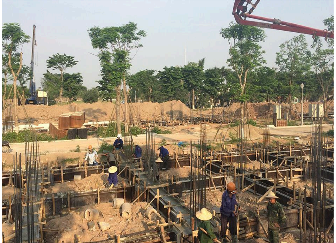
Thi công hệ đà kiềng
