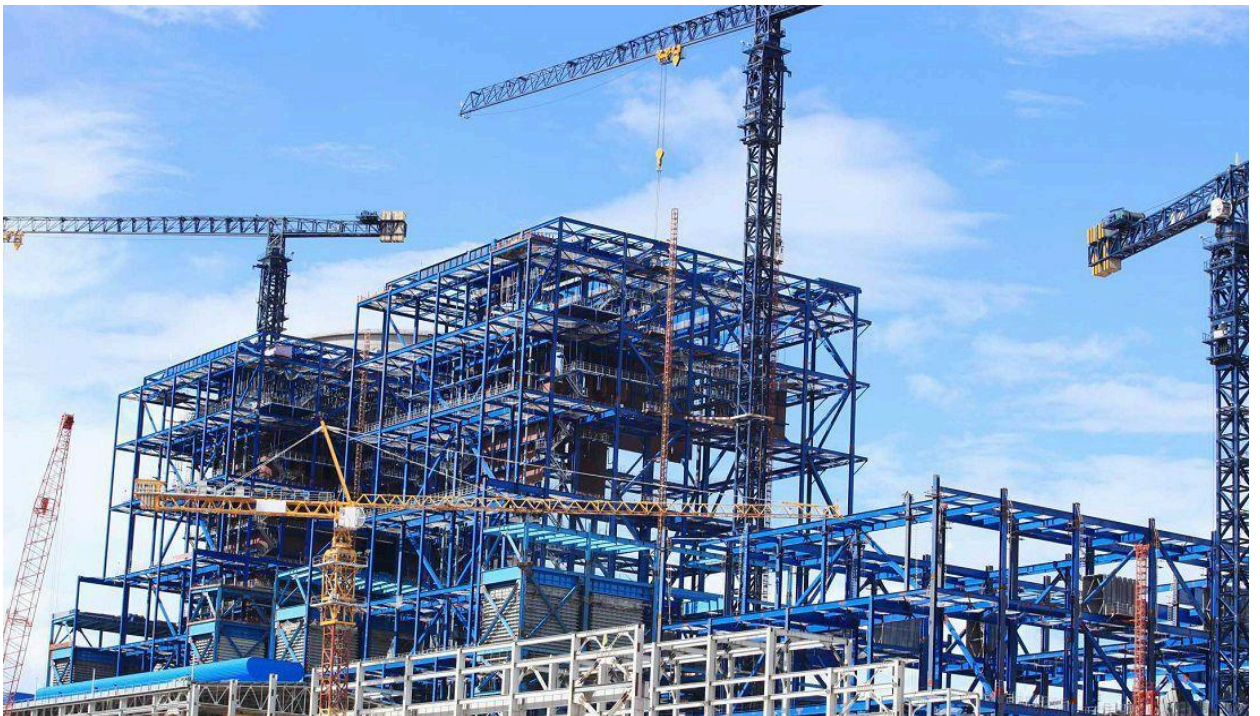
Khung thép nhà công nghiệp nhiều tầng
