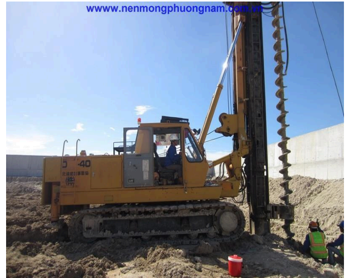
Khoan dẫn hố khoan
