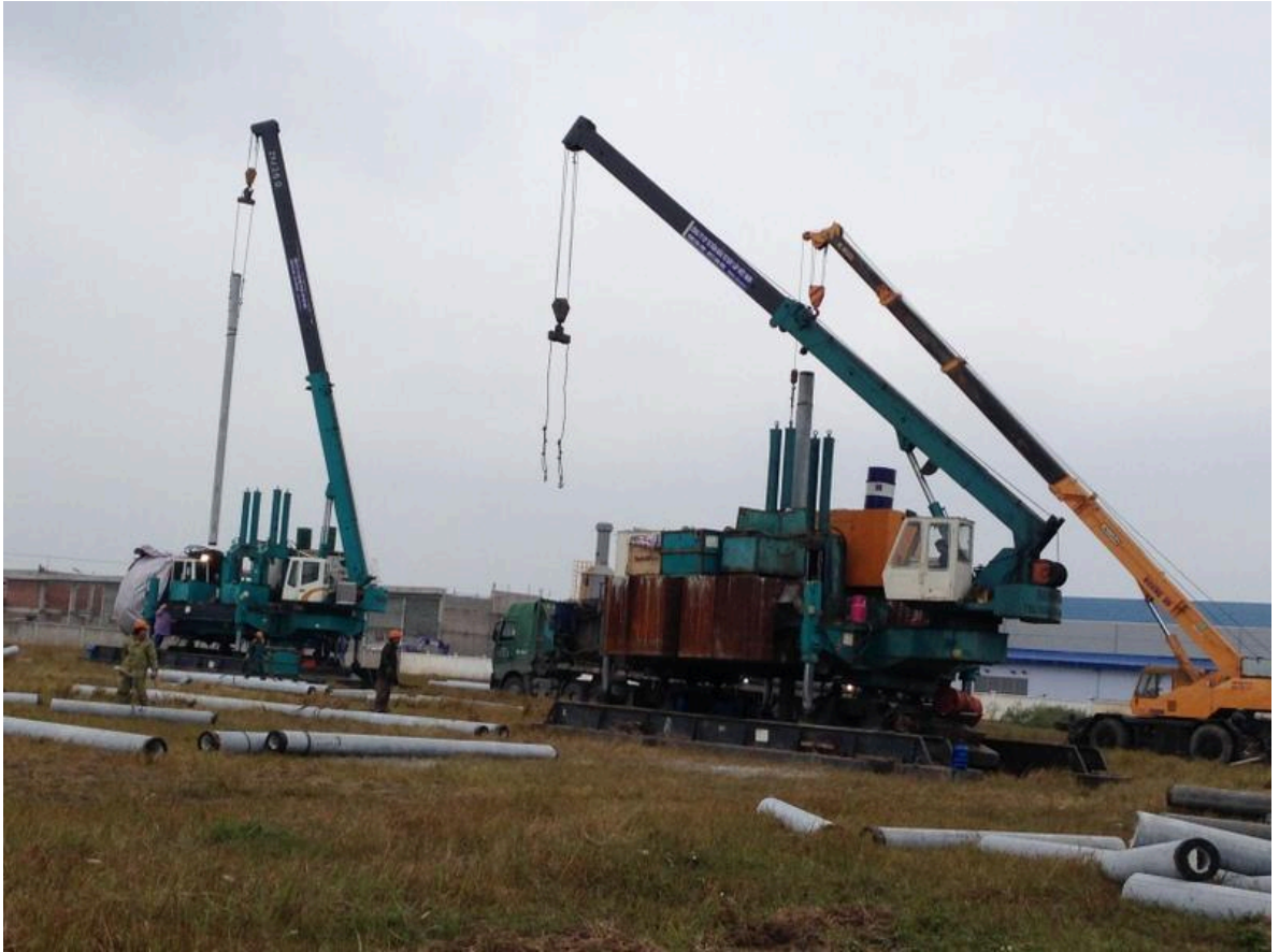
Đa dây treo (dây cao) và móc cầu
