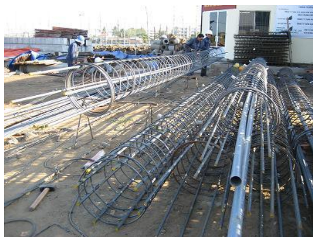
Gia công lồng thép (cốt thép móng cọc khoan nhồi)
