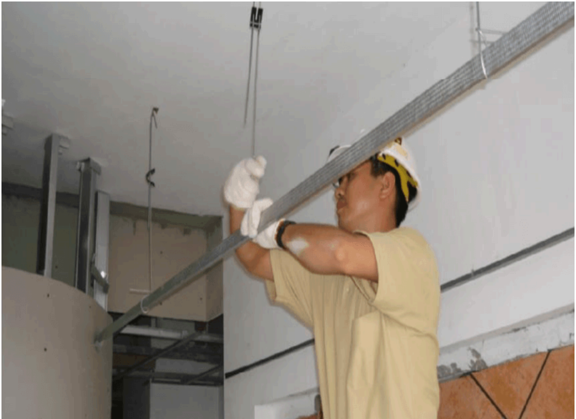
Lắp thanh chính
