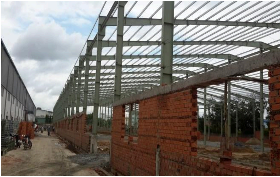
Xây tường bao nhà xưởng
