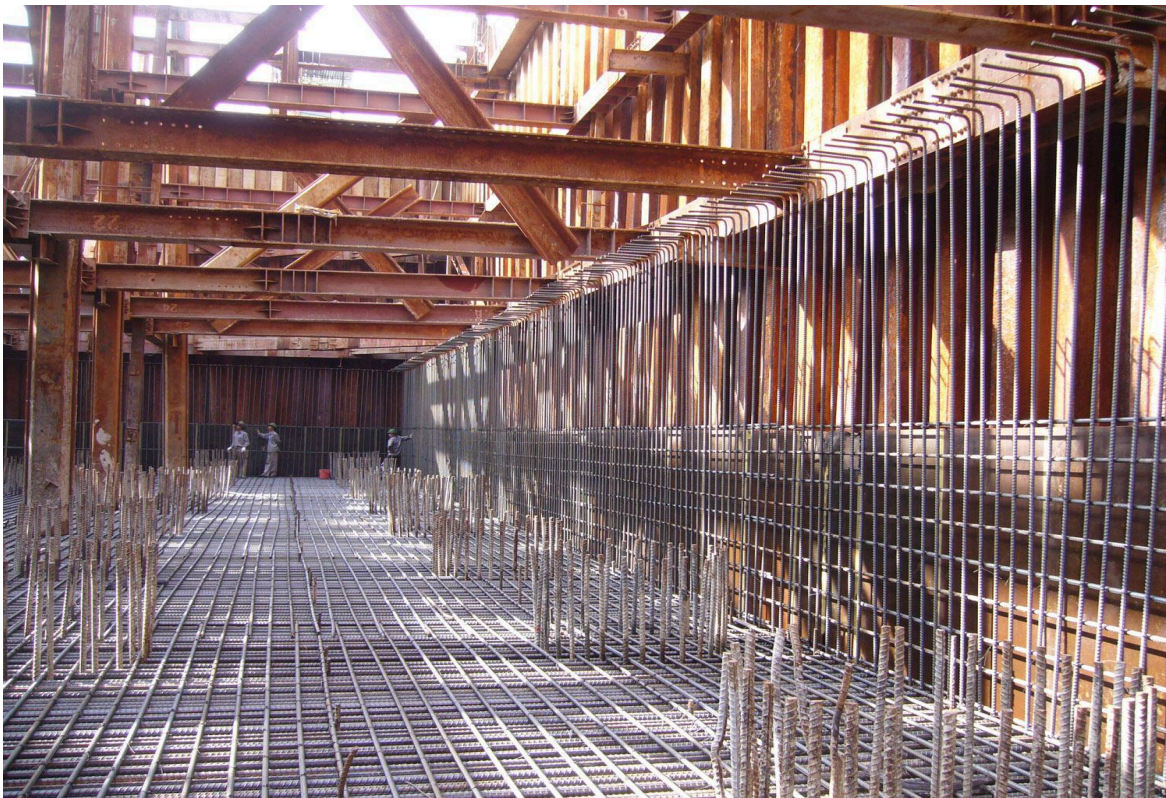
Cốt thép sàn tầng ngầm
