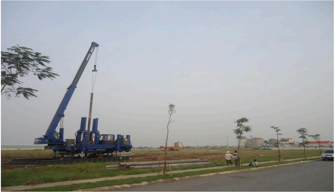
Cẩu lắp trụ
