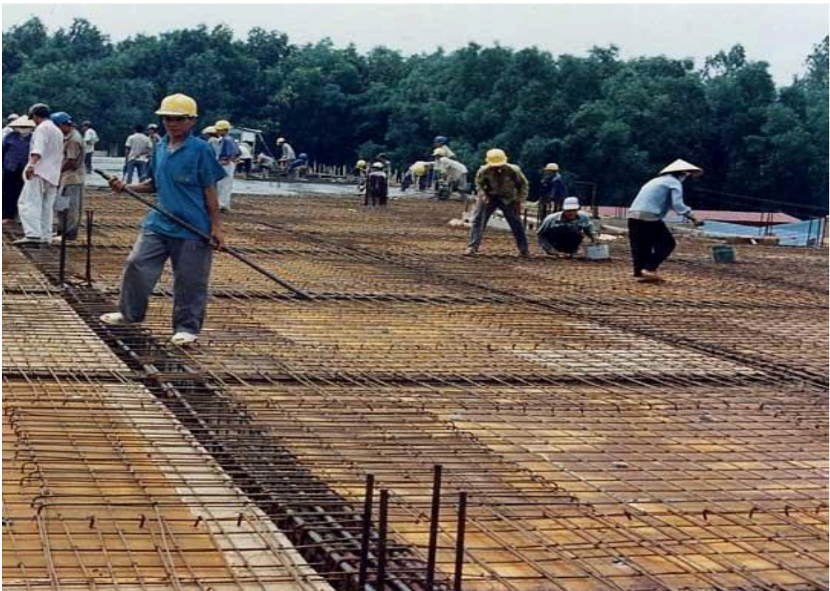
Cốt thép sàn tầng
