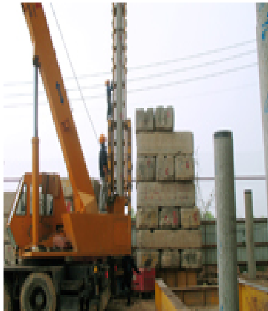
Bê tông giằng máy ép cọc
