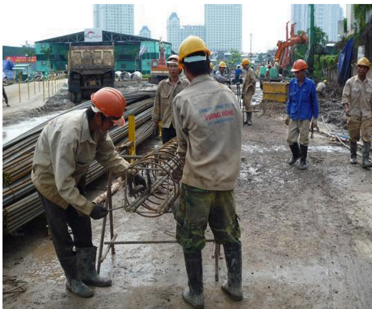
Thi công thép cọc khoan nhồi
