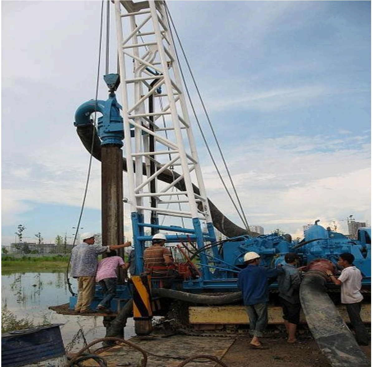
Máy và thiết bị khoan cọc nhồi
