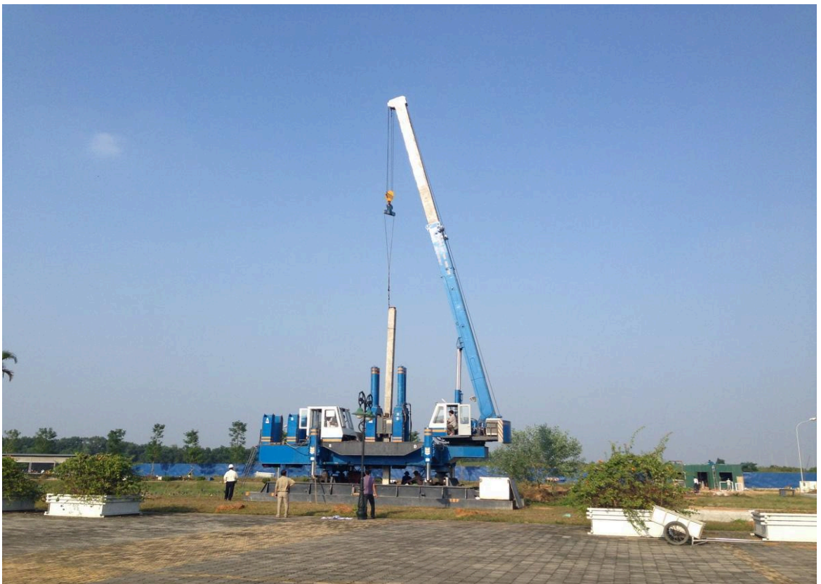
Cẩu lắp cọc
