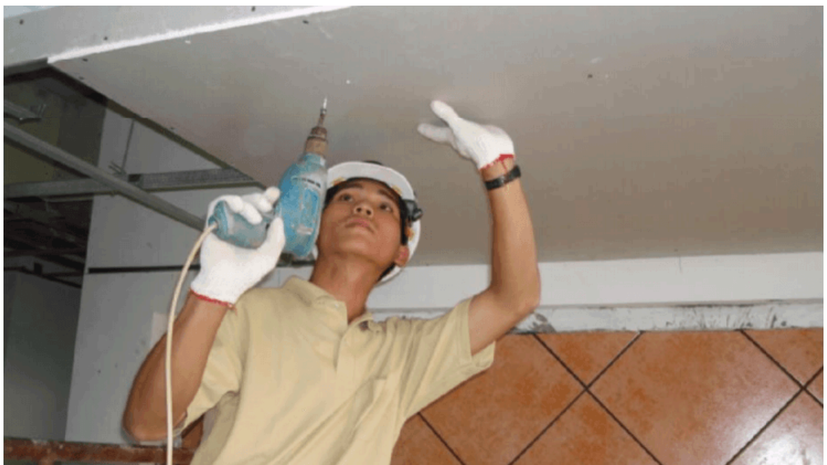
Lắp đặt tấm thạch cao
