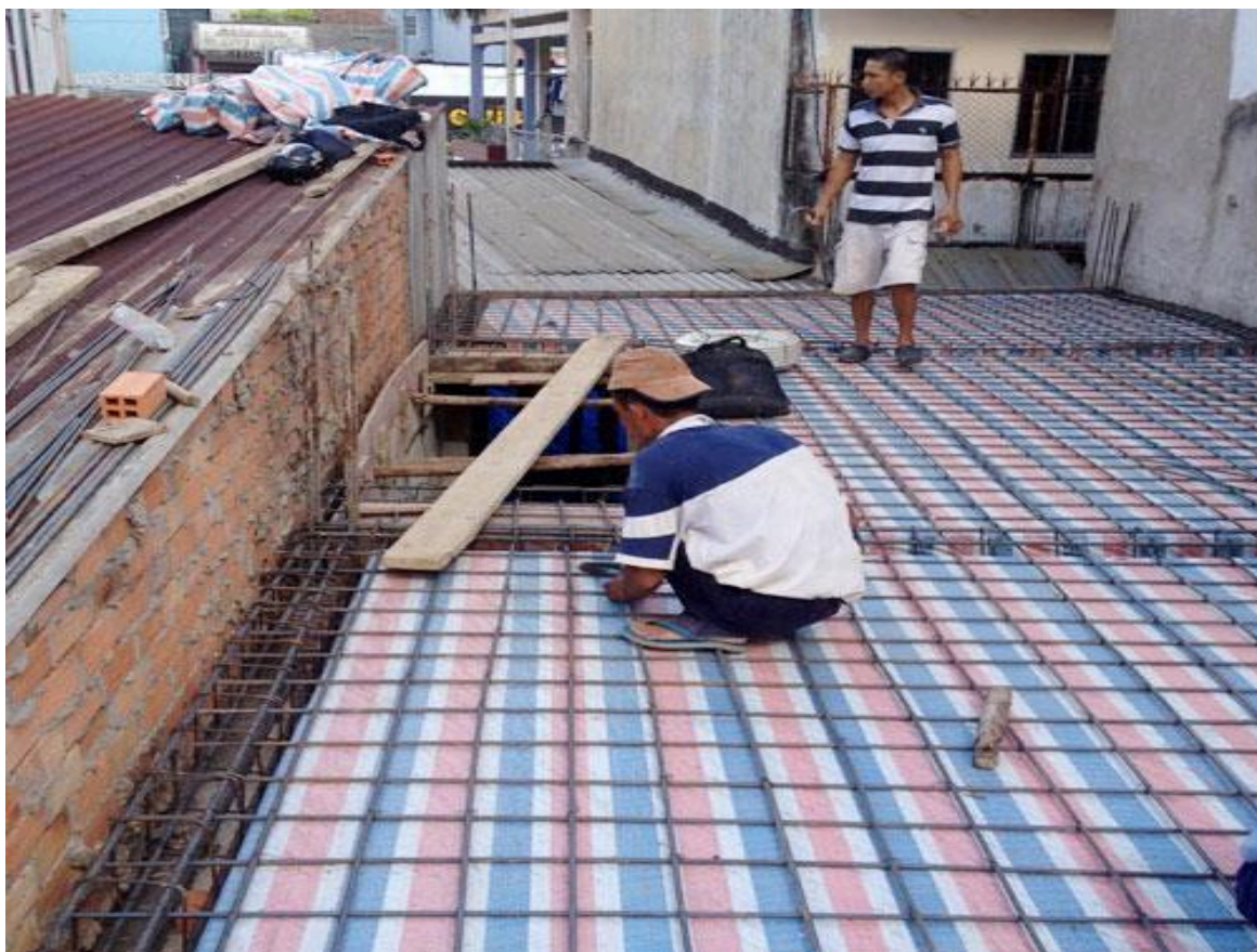
Lót vải địa chống mất nước XM; bố trí thép sàn
