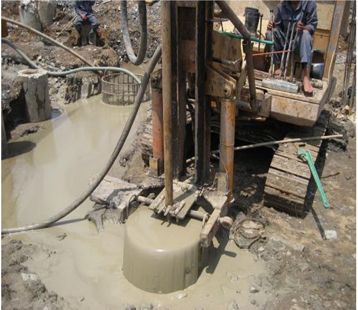
Thi công khoan cọc nhồi
