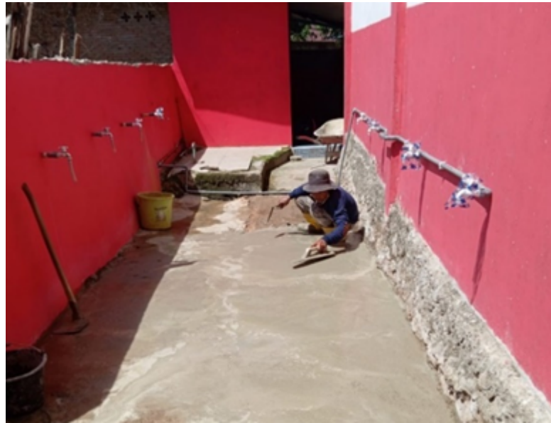
Gambar 5. Proses pembangunan: Pengecoran lantai
