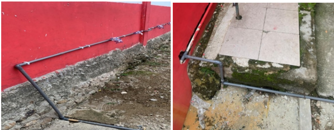
Gambar 4. Proses pembangunan: pemasangan jalur pipa
