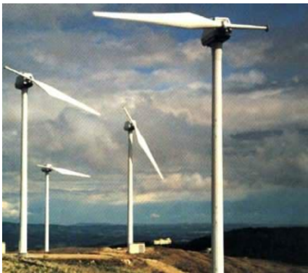
Figura 21. Rotor monopala
